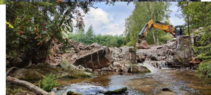
Töllin pato ennen purkua ja purun aikana, Lohja. Kuvat Watec Oy ja lohja.fi
